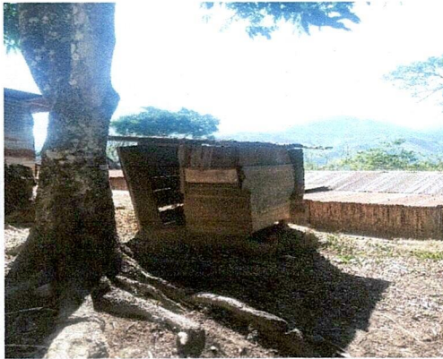
Foto 3: Mejoramiento de Servicio Sanitario.
