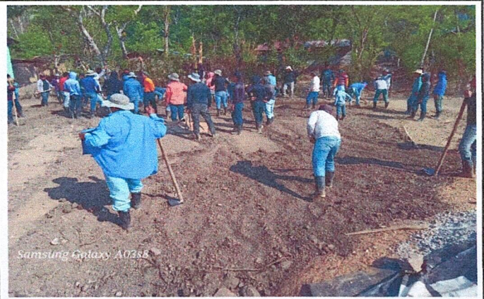
Foto 2: Mejoramiento de dos aulas Tipo Pórtico.
