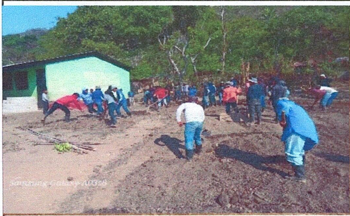
Foto 1: Mejoramiento de dos aulas Tipo Pórtico.
