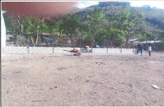
Foto 3: Mejoramiento de dos aulas Tipo Pórtico.
